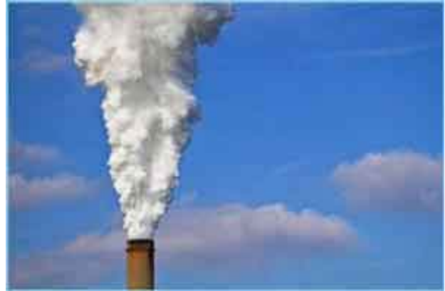
La chimenea de una planta generadora de electricidad en Estados Unidos
